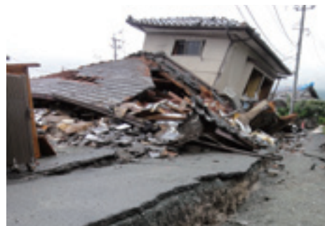
道路严重裂损,木造房屋倒塌(熊本县益城町)
