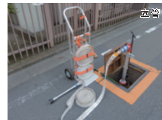
接到路旁的“消火栓”上,利用水压放水。
