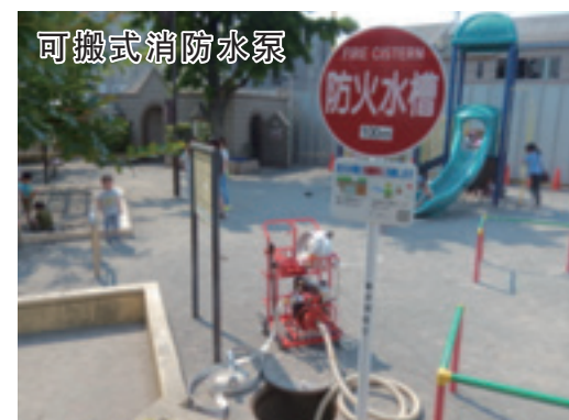
可搬式消防水泵 发动发动机,让水泵从“防火水池”等处抽水喷射。
